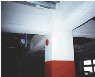
SKK 非膨胀型钢结构防火涂料 (地震后)
